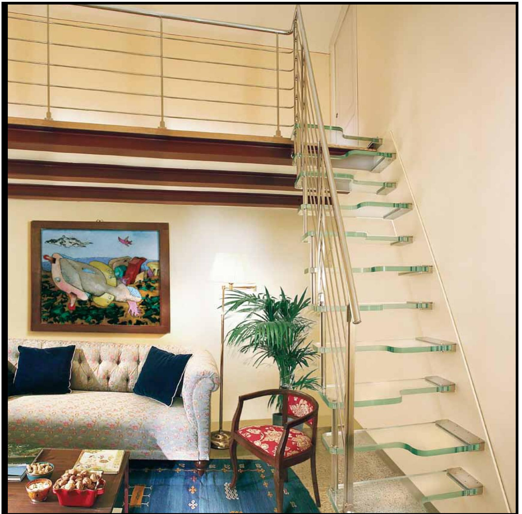
Scala a sbalzo a giorno alla marinara in cristallo strutturale extrachiaro con struttura laterale in ferro verniciato e ringhiera a tondini orizzontali in acciaio inox.
