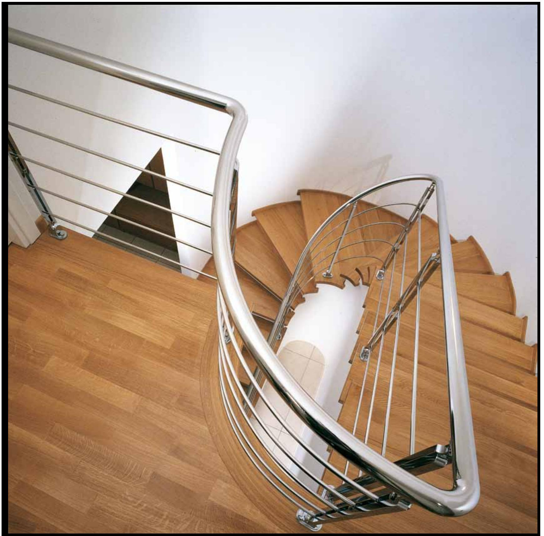
Ringhiera elicoidale a tondini orizzontali in acciaio inox con attacchi sopra i gradini.
