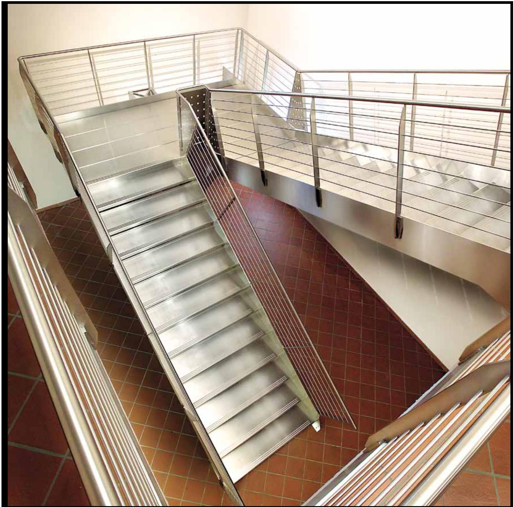
Scala con struttura laterale a fascia in acciaio inox, con gradino e ringhiera a tondini orizzontali in acciaio inox.
