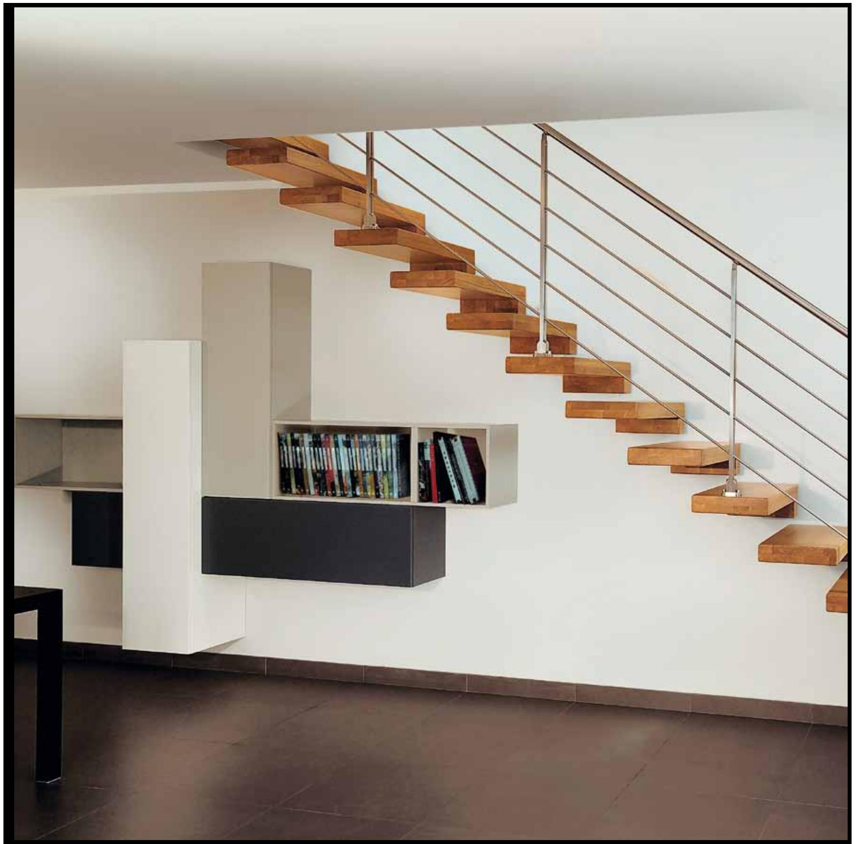
Scala a sbalzo a giorno senza sostegno laterale in rovere massello con ringhiera a tondini orizzontali in acciaio inox.
