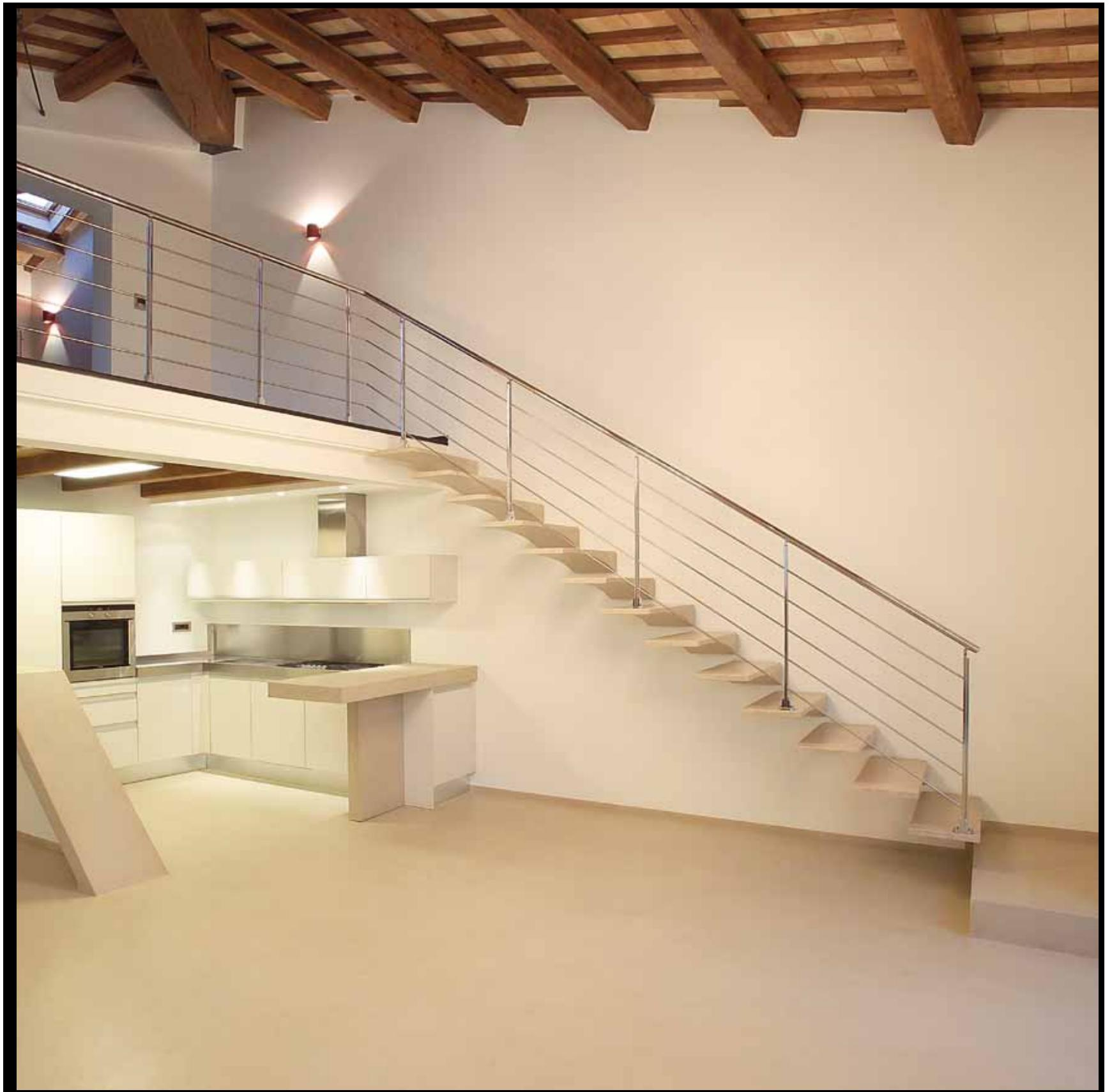
Scala a sbalzo a giorno senza sottogrado con gradini rivestiti in resina e ringhiera a tondini orizzontali in acciaio inox.
