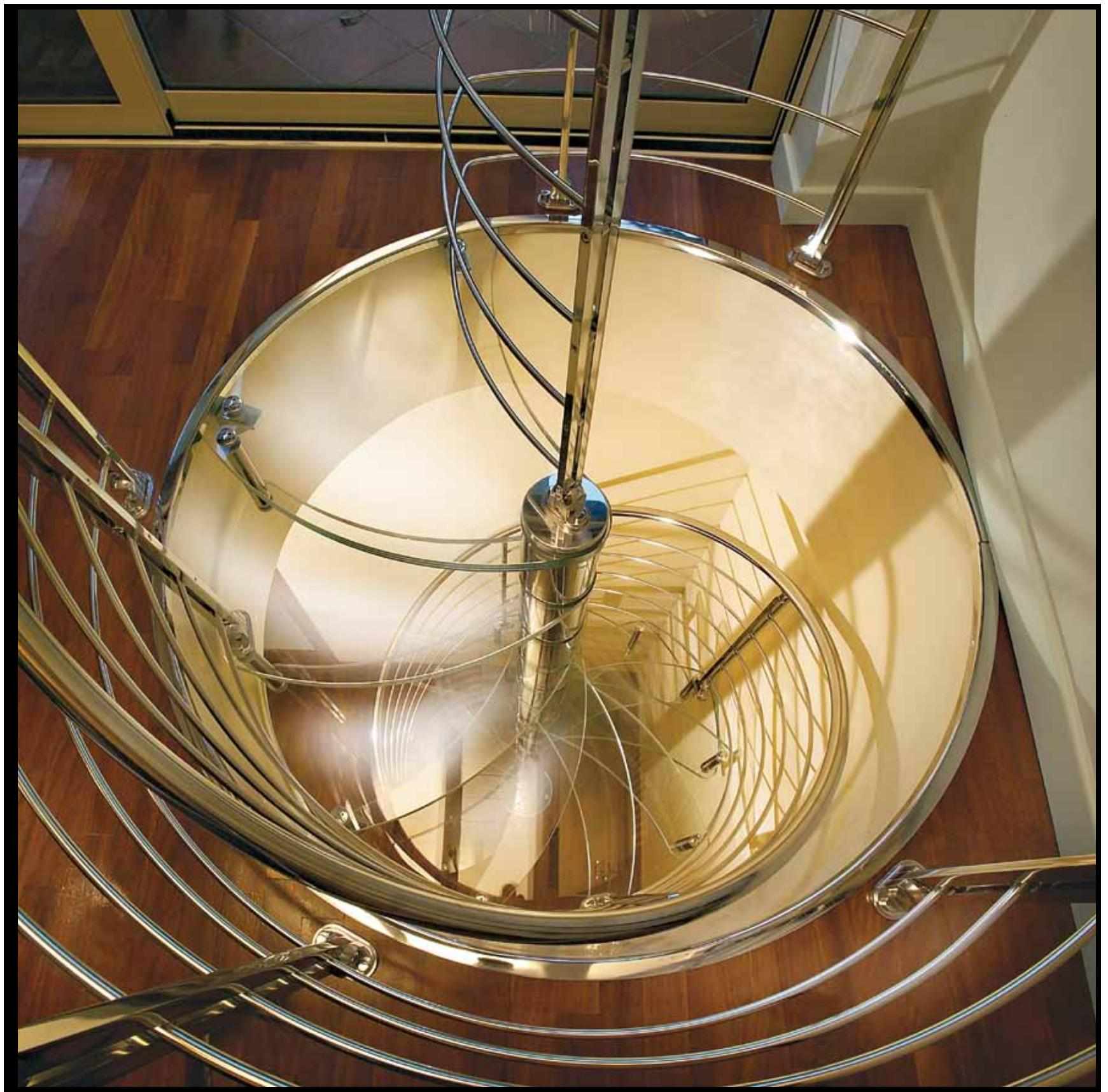
Scala a chiocciola con gradini in cristallo strutturale extrachiaro e ringhiera a tondini orizzontali in acciaio inox.
