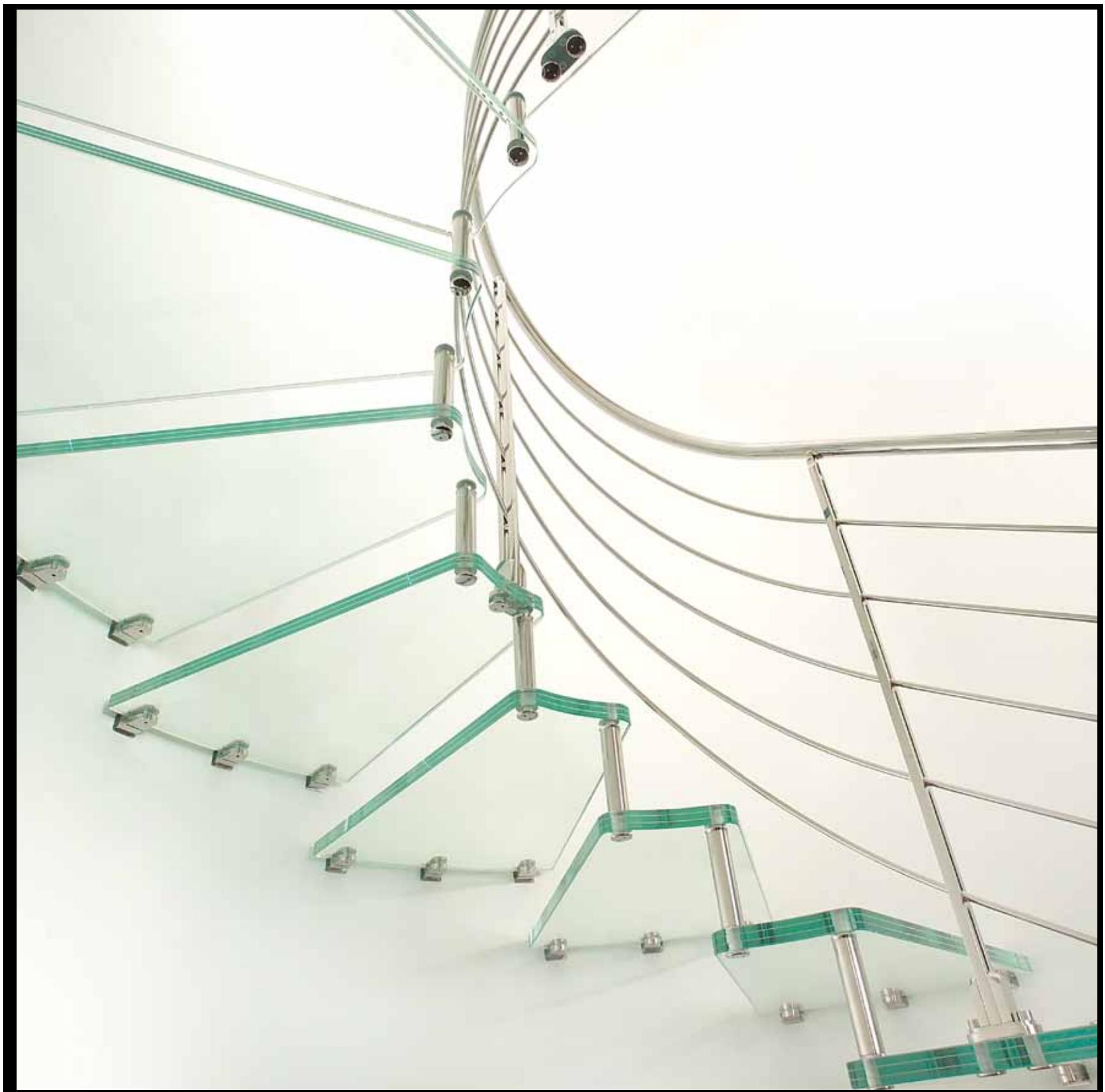
Scala a sbalzo a giorno con gradini in cristallo strutturale extrachiaro e ringhiera a tondini orizzontali in acciaio inox.
