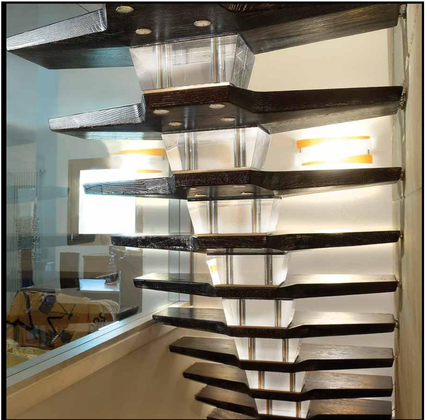
Scala modulare con gradini in massello di rovere ed elementi strutturali in plexiglass con sorgenti luminose.
