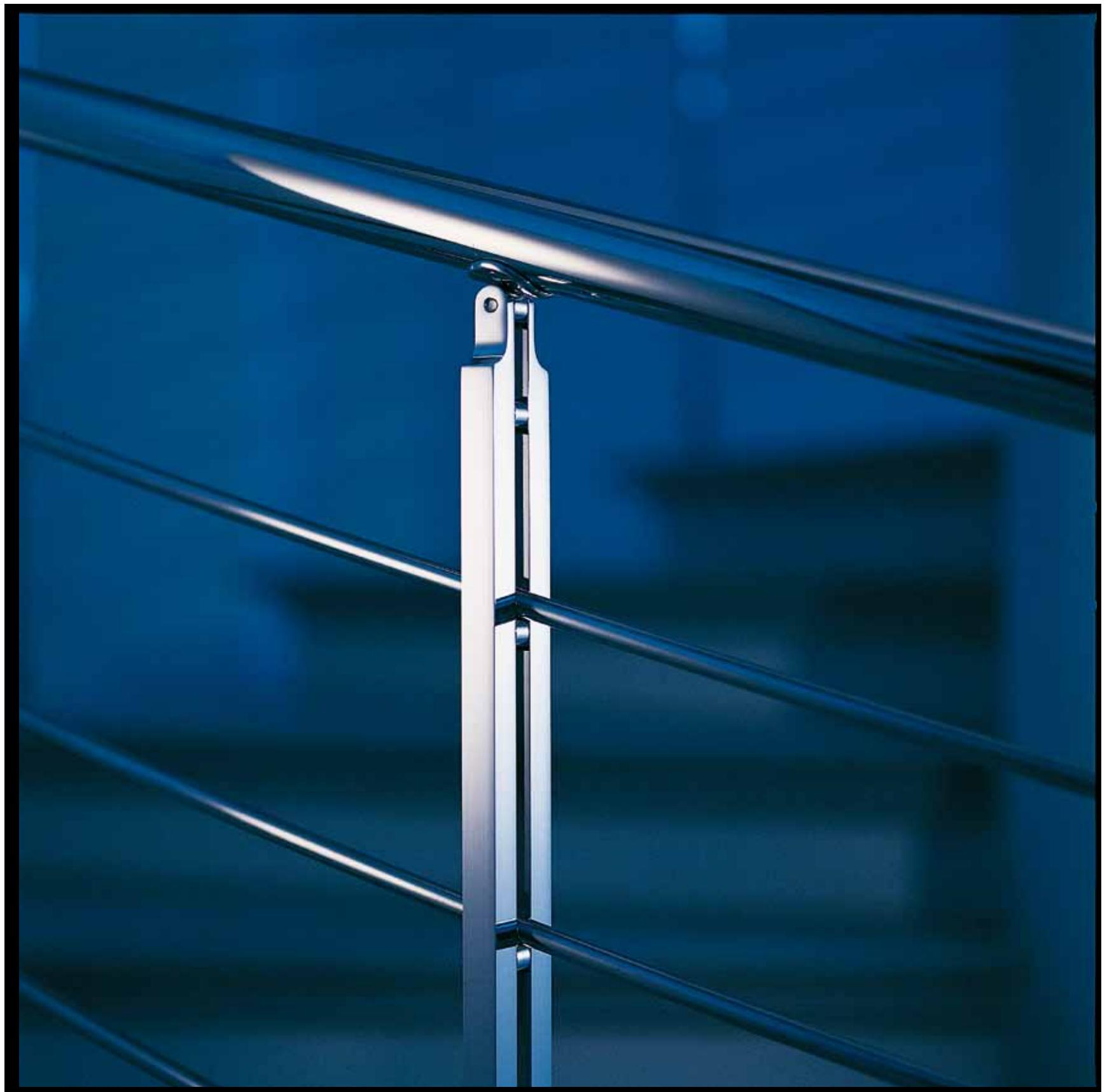
Particolare montante per ringhiera in acciaio inox.
