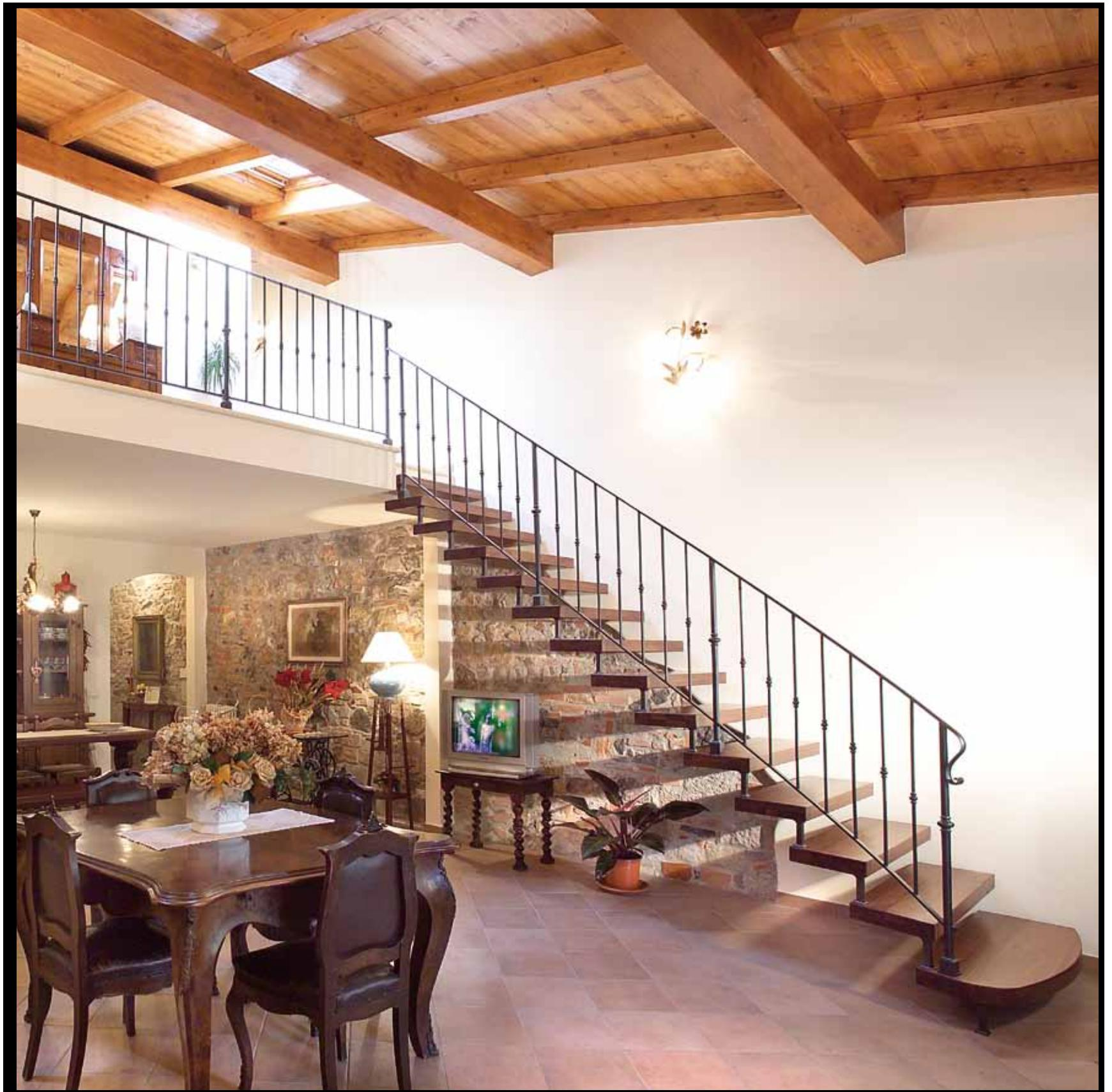
Scala a sbalzo a giorno senza sottogrado con scalini in faggio massello anticato e ringhiera in ferro battuto.
